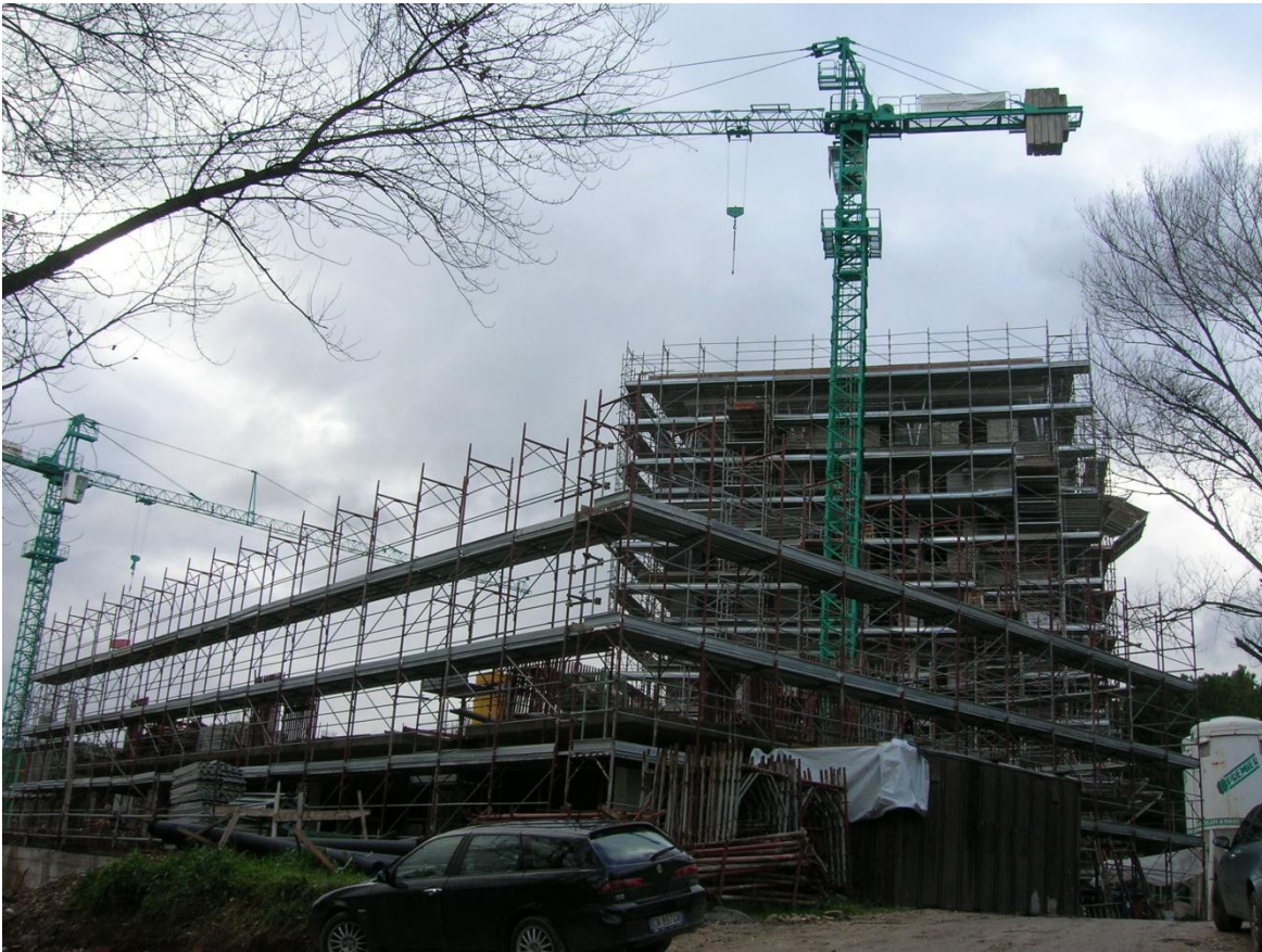
Cantiere Centro Appalti srl , per Urbanizzazione di Via VIII Marzo e Via Malnati (Terni)
